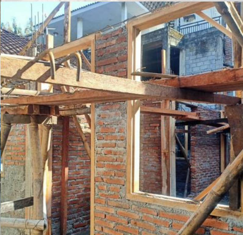
PEMBANGUNAN RUMAH BARU LAYAK HUNI (MEINA AMBARWATI NGANGKURUK RT 05/RW 15)
