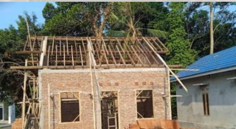
PEMBANGUNAN RUMAH BARU LAYAK HUNI (SUBARYANTI CANDIKARANG RT 03/RW 09)
