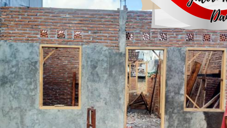
PEMBANGUNAN RUMAH BARU LAYAK HUNI (SUMINAH CANDIKARANG RT 3/ RW9)
